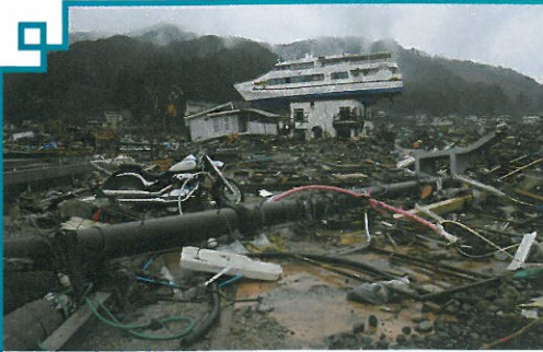
東日本大震災で被災した岩手県大槌町
